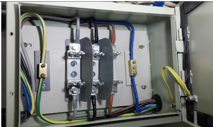
範例 25：✗ 驗收時未有安裝熔斷器
