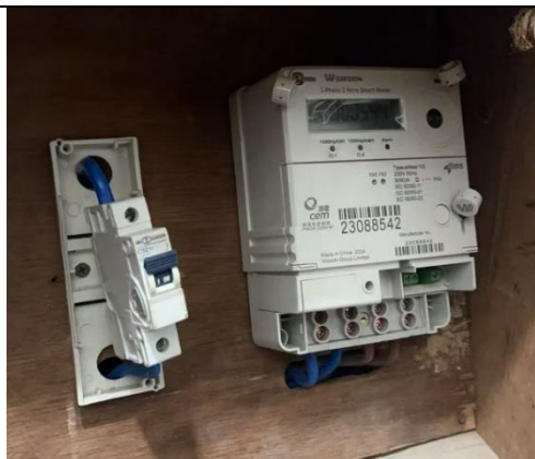
範例 14：✗ 中性線(零線)不正確接入微型斷路器
