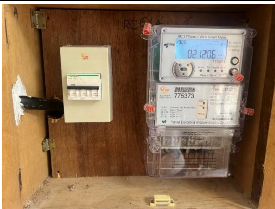
範例 13：✗ 電錶引入線以明線方式安裝
