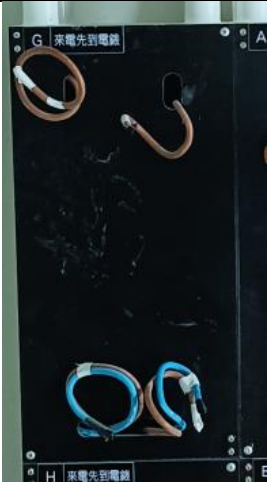
✓ 新錶板需要使用電木板(Bakelite Plate)，開孔須符合規範
