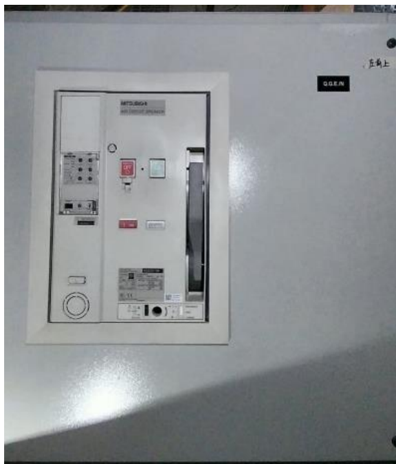
範例 35 : ✖ 掣櫃面未有展示脫扣器的電流設定值
