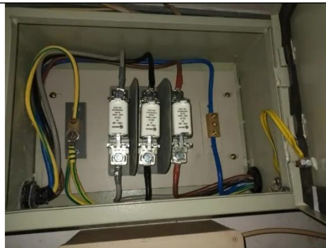
✓ 驗收時須安裝與申請功率匹配之熔斷器
