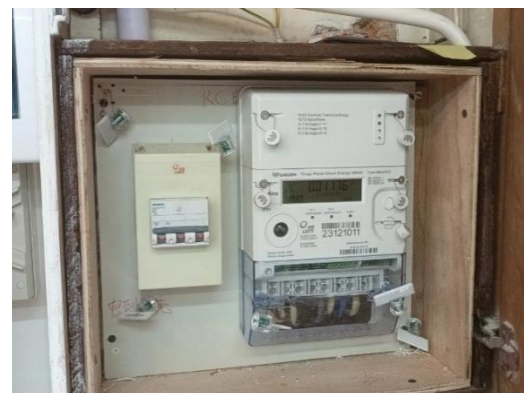
✓ 電錶引入線必須在電錶板後接入
