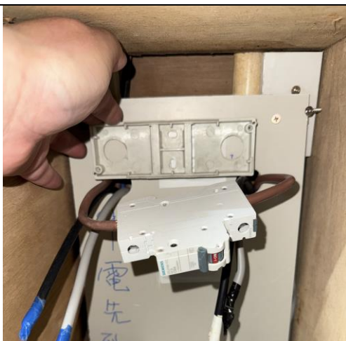
範例 15：✗ 中性線(零線)不得以在電錶位內有接口
