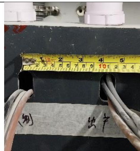
✓ 電錶板開孔尺寸須符合規範
