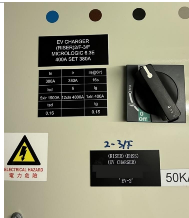
✓ 引入線斷路器上提供標籤顯示其正確額定值(In)及額定過載電流 (Ir)
