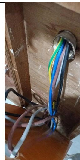
✓ 中性線(零線)過電錶後應直接入戶
