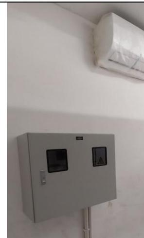
✓ 電氣設備上方應避免安裝有滲漏風險之設備
