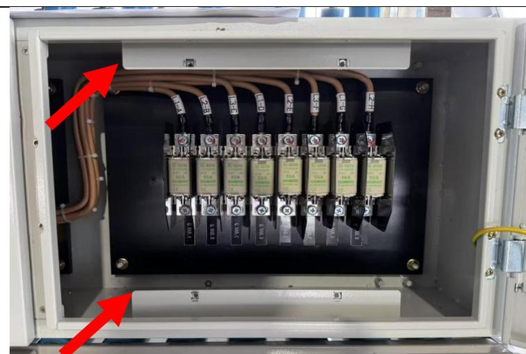
✓ 聚碳酸酯材質的透明擋板須以 L 型角鋼固定
