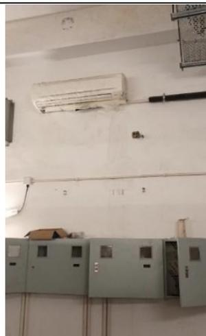
範例 33：✘ 電氣設備上方不得置有水管或冷凝水設施
