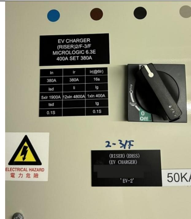
✓ 引入線斷路器上提供標籤顯示其正確額定值(I<sub>n</sub>)及額定過載電流(I<sub>r</sub>)
