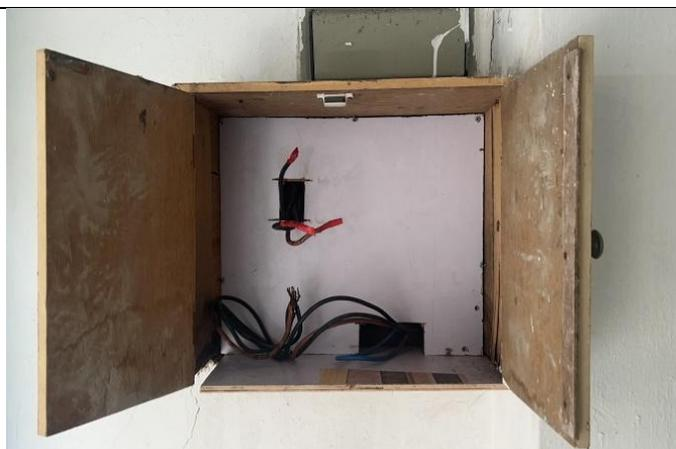
範例 19：✘ 電錶板未有使用電木板(Bakelite Plate)，開孔不符合規範，
