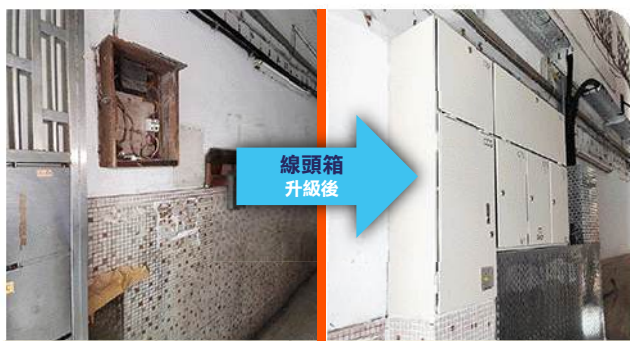
供電點升高至約1.5米，減低電力裝置受水浸風險。
